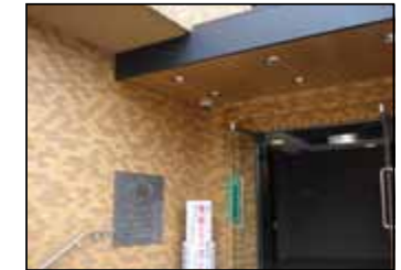
正面出入口ドームカメラ
