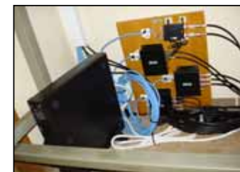
LAN配線工事
