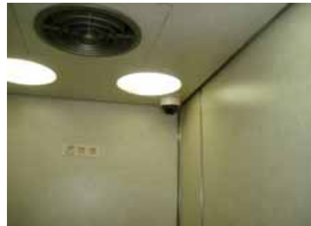
エレベータカメラ
