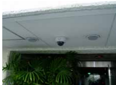
エントランスカメラ
