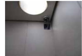
エレベータカメラ
