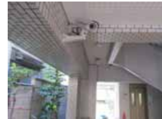
正面エントランスカメラ
