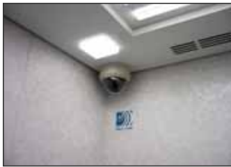
エレベーター昇降機内 エレベーター専用カメラ
