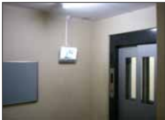
エレベーターホールモニター 昇降機内監視モニター
