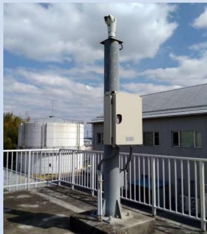
TPS-HD370NSW 光学30倍 遠隔サーチ 高精度ハイパーPTZカメラ
