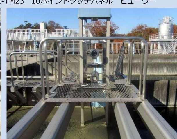
浄水池 水中カメラ・水中ライト 手動昇降機用架台
