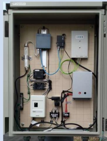
カメラ雷保護・EMC PTZカメラ制御盤 水中カメラ制御盤
