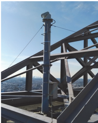
広域監視高所 24階屋上 1,152倍低照度フルHDカメラ 東西に各1台配置
