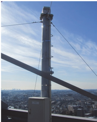
広域監視高所 24階屋上 1,152倍低照度フルHDカメラ 東西に各1台配置
