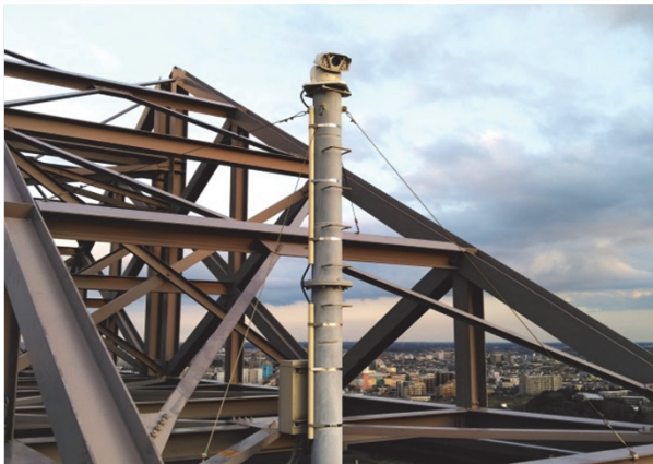
広域監視高所 24階屋上 1,152倍低照度フルHDカメラ 東西に各1台配置
