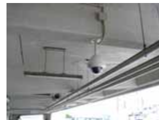
場内通路巡回カメラ
