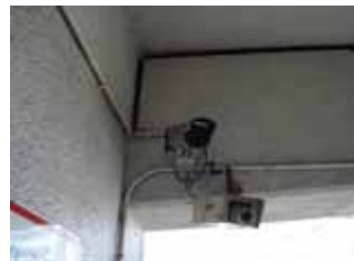
駐車場出入口ゲートカメラ
