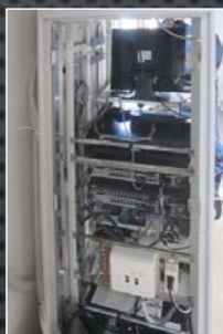
高所カメラ 高速通信システム架
