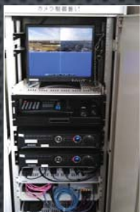
高所カメラ 高速通信システム架
